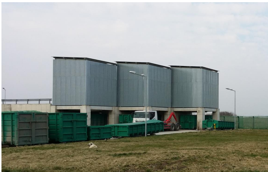
Fig. II.2.6.7.2. - Centru de colectare deșeuri Deta
