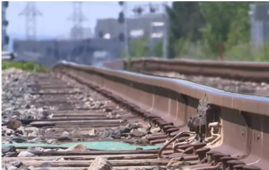
Foto XV.26. Fenomenul de dilatare a șinelor de cale ferată sub influența temperaturilor extreme pozitive (Sursa: libertatea.ro)
